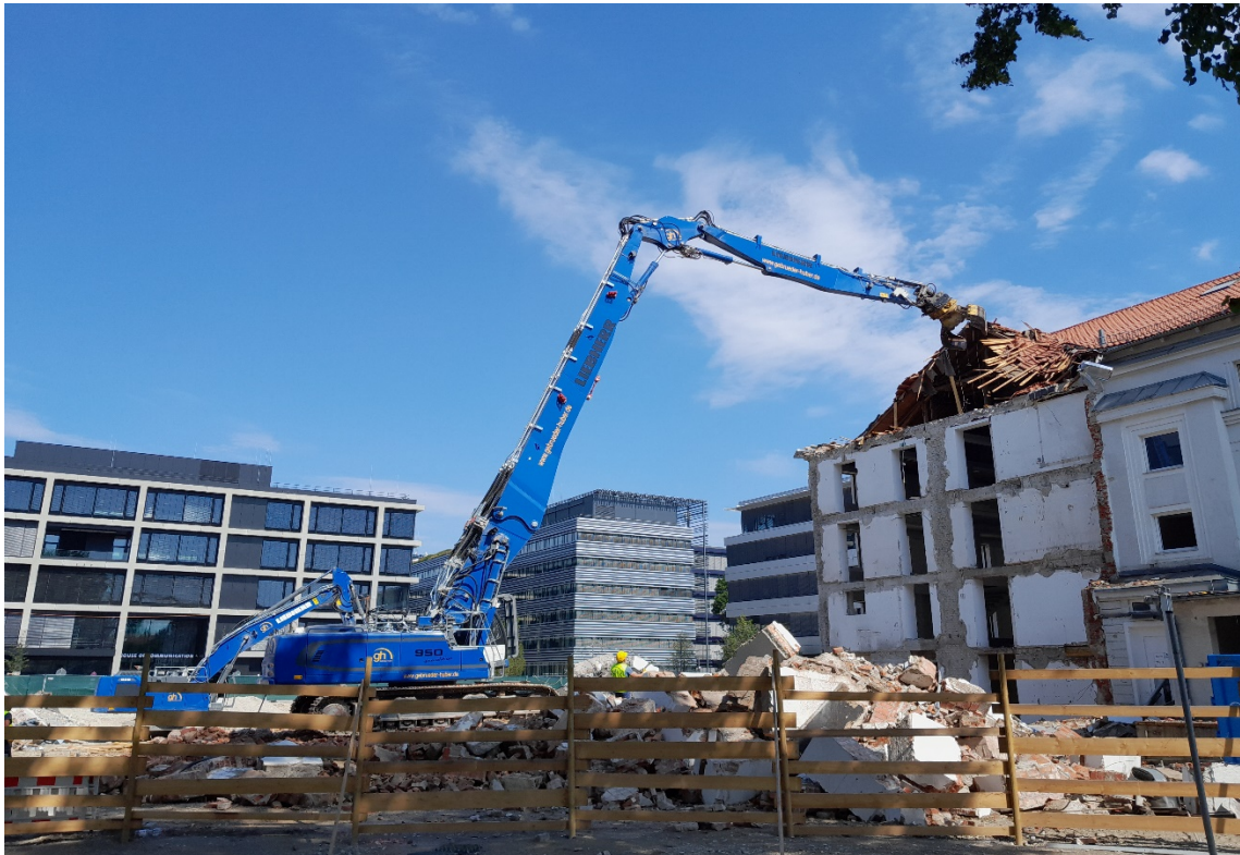
Abbildung 6: Abriss als Einsatzoption (Gebrüder Huber Bau GmbH)
