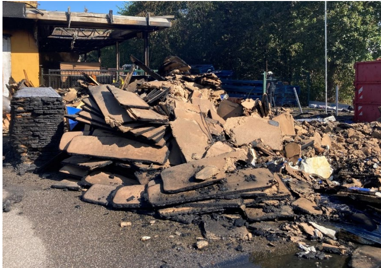
Abbildung 7: Lagerung von ausgebauter Holzfaserdämmung birgt die Gefahr eines erneuten Brandereignisses (Ronald Richter)
