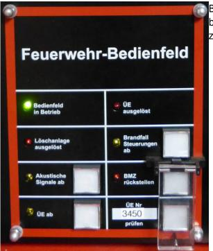
Betätigte Tasten leuchten gelb. Vor Einsatzende sind betätigte Tasten wieder in den Ausgangszustand zurückzusetzen, sodass diese nicht leuchten.
