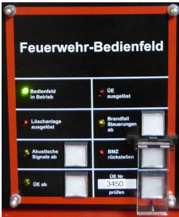
Betätigte Tasten leuchten gelb. Vor Einsatzende sind betätigte Tasten wieder in den Ausgangszustand zurückzusetzen, sodass diese nicht leuchten.
