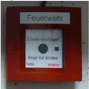
Der Hauptmelder befindet sich meist in der Nähe der BMZ. Er stellt die Übertragungseinrichtung zur Feuerwehr dar, funktioniert also auch wenn die BMA abgeschaltet oder ausgefallen ist.
