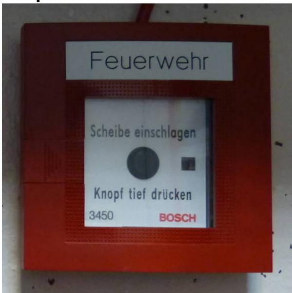
Der Hauptmelder befindet sich meist in der Nähe der BMZ. Er stellt die Übertragungseinrichtung zur Feuerwehr dar, funktioniert also auch wenn die BMA abgeschaltet oder ausgestanden ist.
