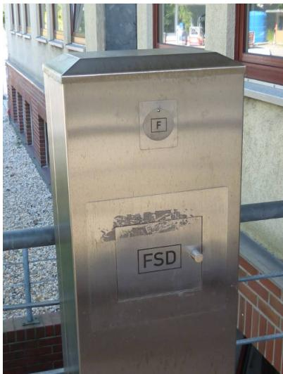
Ein FSD 3 dient als Ersatz für eine nicht ständig besetzte Empfangsstelle und ermöglicht der Feuerwehr den Zutritt zu allen Bereichen des Objekts. Aufgrund der Sensibilität des eingelagerten Schlüssels wird das FSD 3 durch die BMA überwacht und gegen Sabotage überwacht. Des Weiteren werden alle Aktionen protokolliert, beispielsweise auch die rechtmäßige Entnahme des Schlüssels im Alarmfall. Um ein einfaches Auffinden zu ermöglichen, befindet sich in der Nähe des FSD 3 eine Blitzleuchte.
